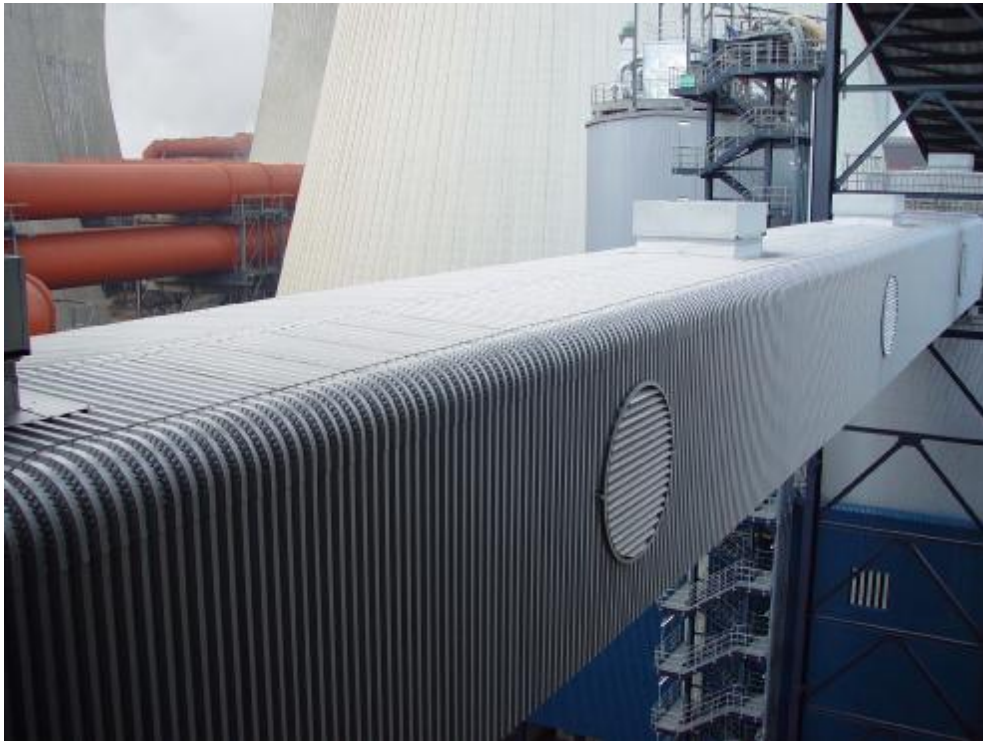
Kraftwerk Niederaußem - Kohlebandbrücken
